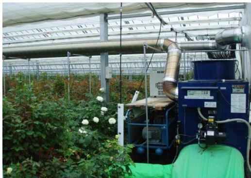
加温器の煙突の排熱を再利用
